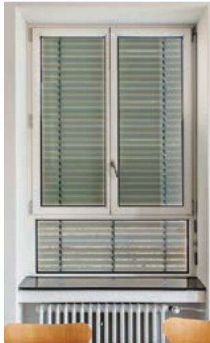
Abb. 26 Tageslichtsituation im Raum bei außenliegendem Sonnenschutz l.) Vollständig geschlossener Sonnenschutz m.) Unterer Behang geschlossen, oberer Behang mit Tageslichtlenkung r.) Lamellen in Horizontalstellung. Quelle: S. Winterwerber, KIT
